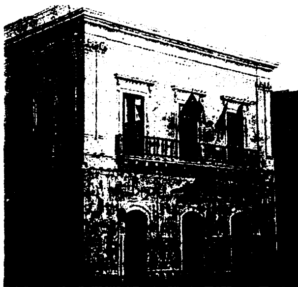
L'EDIFICIO COMUNALE DI VIA ROMA
