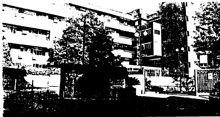
L'ingresso dell'ospedale «Umberto I». Il piano di rientro prevede l'avvio di nuovi servizi ma resta il problema, oggettivo, del blocco dei concorsi
